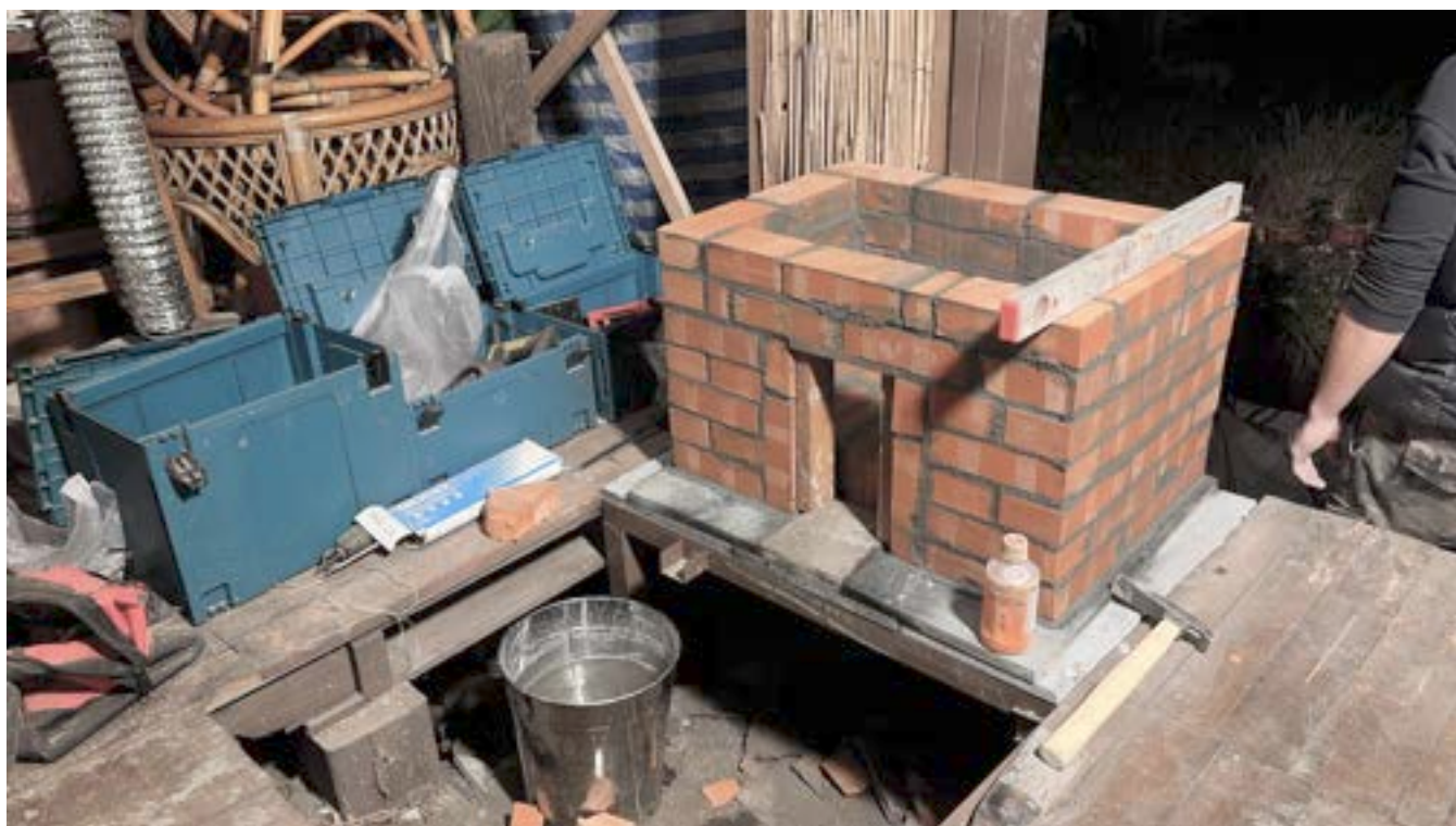
拆除地爐改成壁爐：地爐生火的時候全場會充滿黑煙，都無法在營業時間取暖，因此我計劃蓋更好排煙的壁爐。
