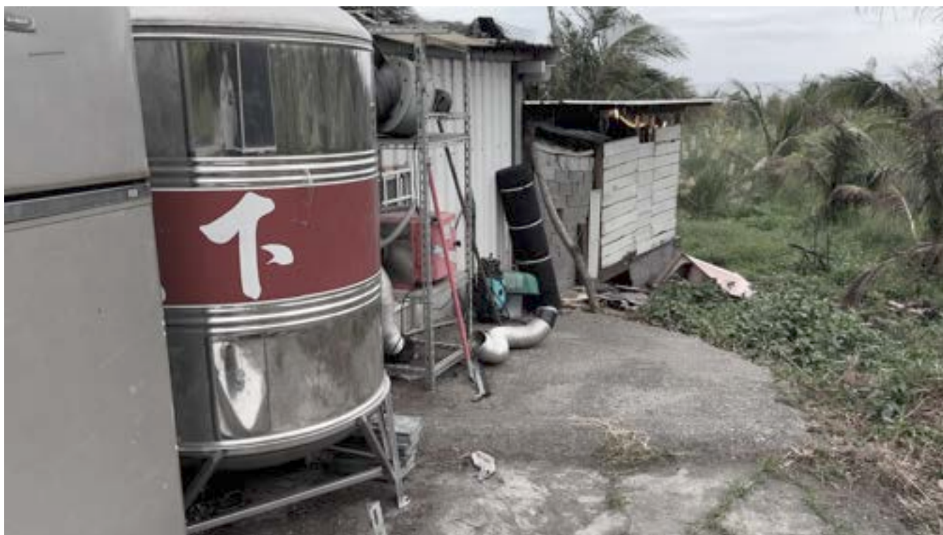
水塔：原本沒有水塔和加壓馬達，導致家裡的水壓非常小，只要有人在廚房用水，浴室就沒有水。
